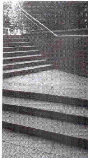
Fot. Schody do Izby Przyjęć
